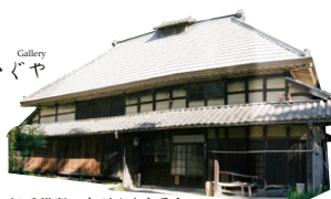
江戸後期に建てられた古民家
